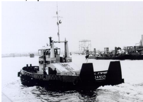
Bild 3 (SCHOTTEL_100 Jahre_03.jpg) Janus, o primeiro rebocador com hélices de leme SCHOTTEL
