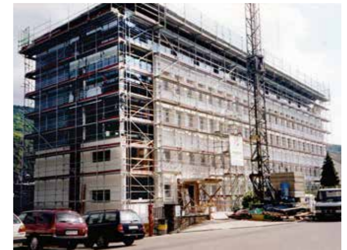
Die Aufstockung des bestehenden Verwaltungsgebäudes um die Jahrtausendwende greift den gestiegenen Raumbedarf auch in der Administration auf.
