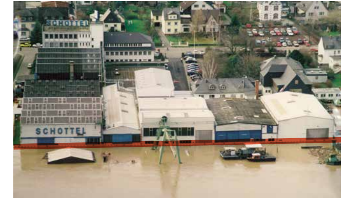
Das Spayer Produktionsgelände in direkter Rheinnähe ist bei Hochwasser gefährdet. Ab 1989 hilft eine mobile Schutzwand, die direkt vor die Hallen montiert wird, den Betrieb aufrechtzuerhalten; im rechten Bild rot markiert (Bild links 1988, Bild rechts 1990er-Jahre).
